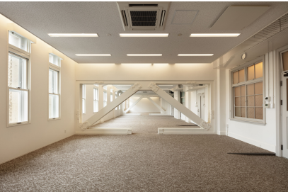
耐震補強 （撮影：稲住写真工房）
