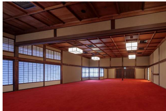
玄関棟内観（格天井、欄間彫刻保存） (撮影:株式会社エスエス 大阪支店 秋田広樹)
