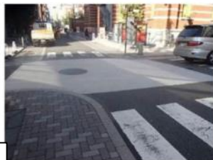
薄層カラー舗装及び小舗石舗装
