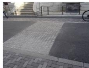
薄層カラー舗装及び小舗石舗装
