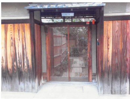
※ 高塀の杉皮貼り工事に対して，補助金を利用いただいた例
