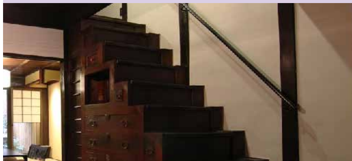
大切に使われてきた収納と一体となった階段
