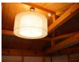
内部から見える構造躯体
