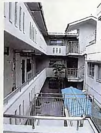
3階の階段から廊下を見たところ
