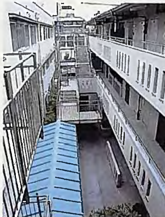
3階廊下の奥から階段部分(立体路地)を見たところ
