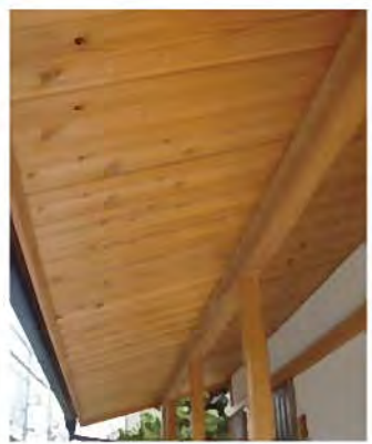
軒材に杉板を使用した施工例
