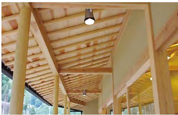
軒の柱と垂木は北山丸太、野地板・梁は京都市内産の杉を使用
