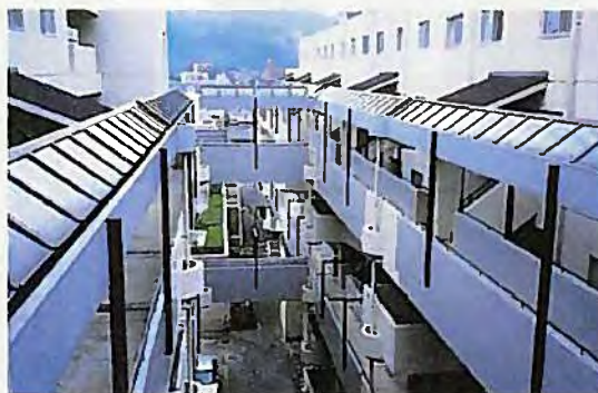
階段を立体的な路地空間のようにデザインしたことにより、廊下、階段を行き交う人とお互いの姿を確認することができる。
