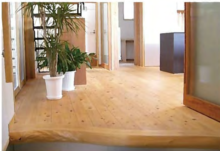
桧板を使用した床と桧の曲がりを利用した上框
