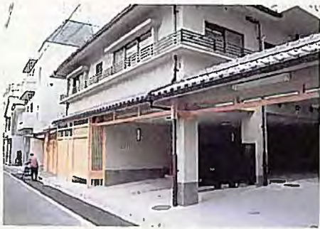
通り北側から見た外観
