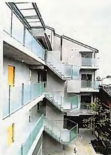
各階廊下部分
