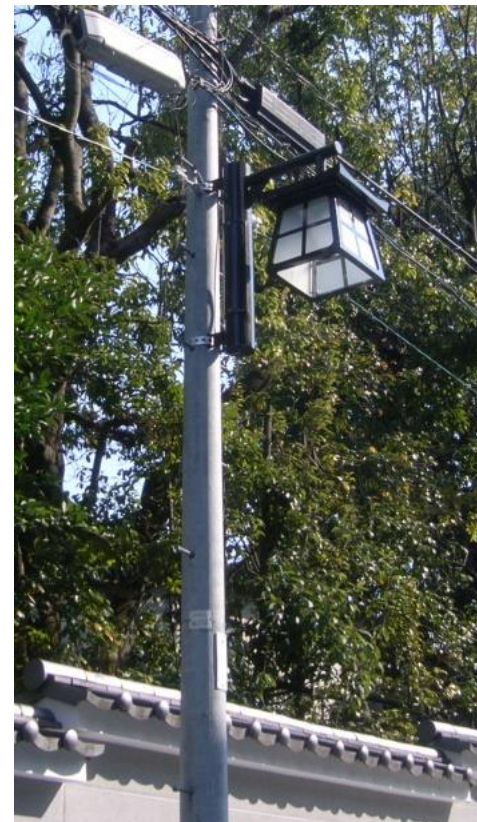
景観に配慮した照明灯を設置 (照明は暖色系に統一)
