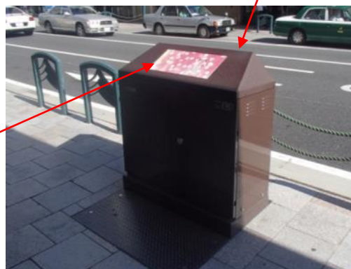
地上機器美装化の状況
