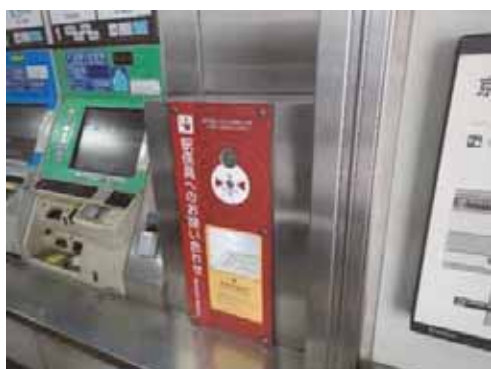
東福寺駅（京阪） 駅員呼び出しボタンの設置
