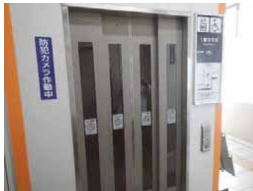
(ア) エレベーターの設置
