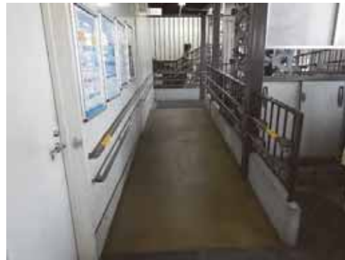
(イ) 階段・スロープの 手すりの設置・改善
