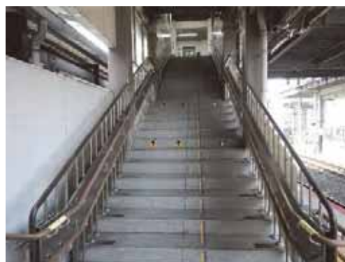
(イ) 階段手すりの改良
