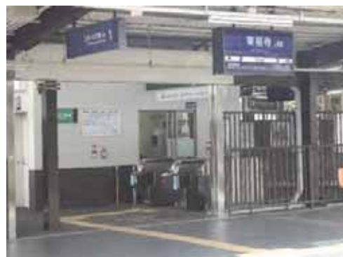
東福寺駅（京阪） ＪＲのりかえ口の新設
