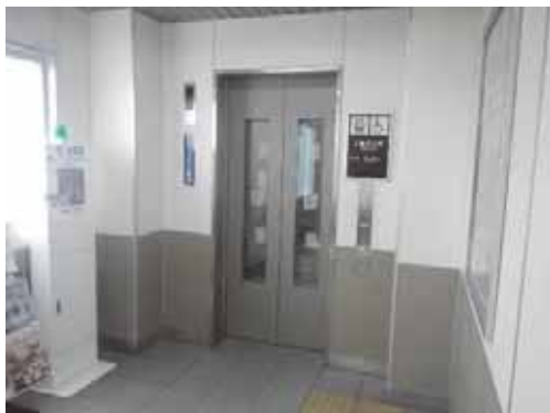
(ア) エレベーターの設置
