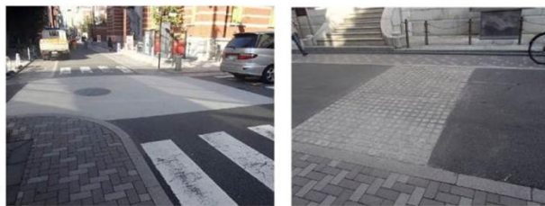
薄層カラー舗装及び小舗石舗装
