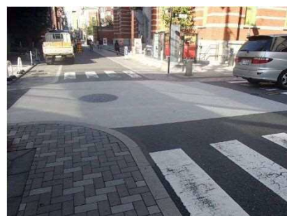
写真-5 薄層カラー舗装の実施状況
