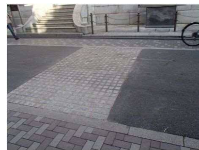
写真-6 ピンコロ石舗装の設置状況
