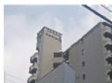
3. 下京区河原町松原（塔屋看板・あり）
