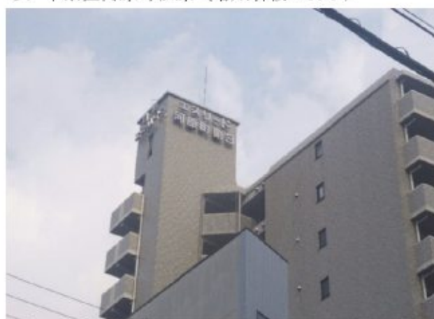
3. 下京区河原町松原（塔屋看板・あり）
