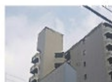
4. 下京区河原町松原（塔屋看板・なし）
