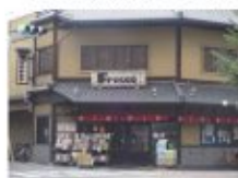
31. 上京区堀川下立売（スーパーマーケット）
