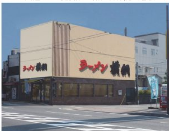
56. 国道171号線沿い 南区吉祥院（看板・白）
