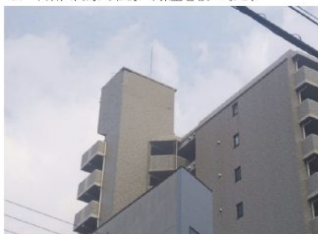
4. 下京区河原町松原（塔屋看板・なし）
