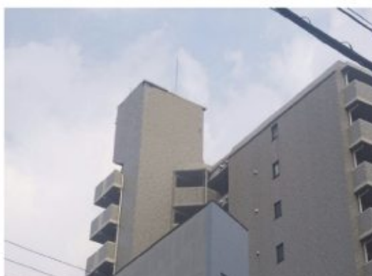
4. 下京区河原町松原（塔屋看板・なし）
