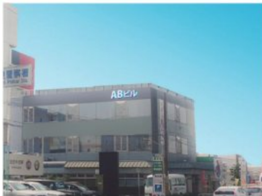
5 4. 国道1号線沿い 伏見区下鳥羽 （屋上看板・なし）
