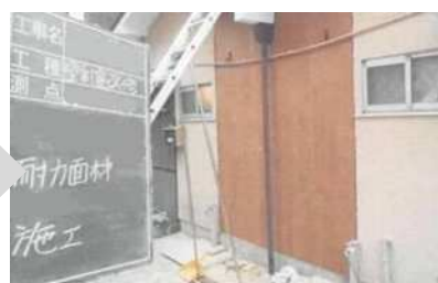
構造用合板の設置
