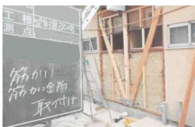
筋交い、金物の設置
