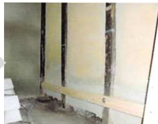
根がらみの設置
