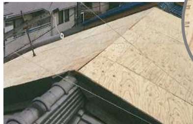
屋根面の構造用合板の設置
