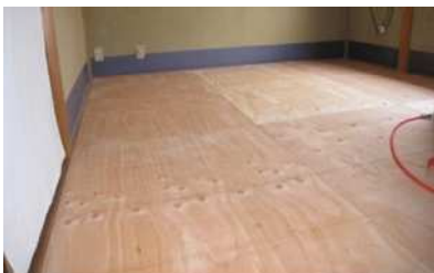
2階床組の構造用合板の設置
