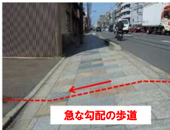
歩道が狭く、勾配の急な箇所が存在
