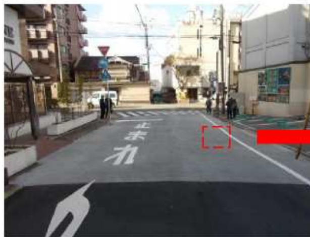
◆石畳風舗装試験施工
