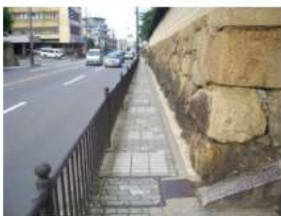
歩道が狭く、段差や勾配の急な箇所が存在
