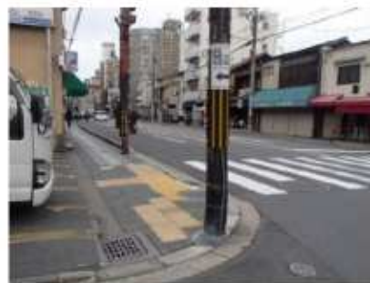
電柱等が歩行者の支障となっている 等
