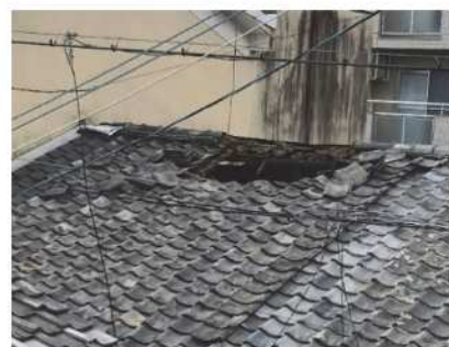
● 屋根が大きく破損するなど、危険な状態にある空き家
