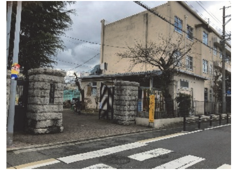
● 「洛中小学校」は、中京区における最初の小学校統合校として平成4年4月に開校
