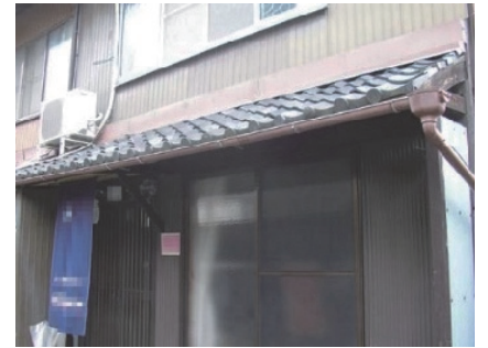
● 前面道路(路地)も狭く、100m以内に保育所が隣接する簡易宿所
