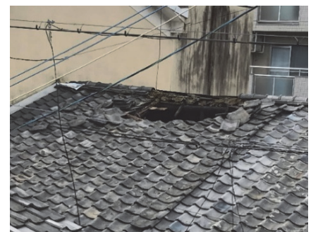
● 屋根が大きく破損するなど、危険な状態にある空き家
