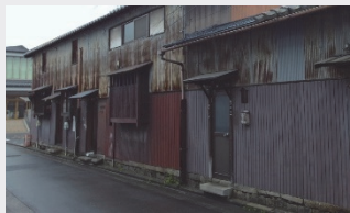
圓通寺長屋 改修前の外観
