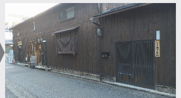
圓通寺長屋 改修後の外観
