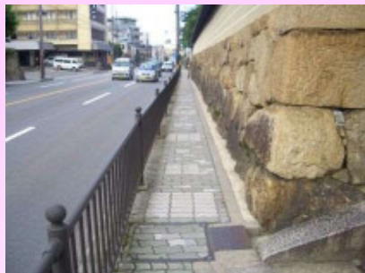
歩道が狭く、段差や勾配の急な箇所が存在
