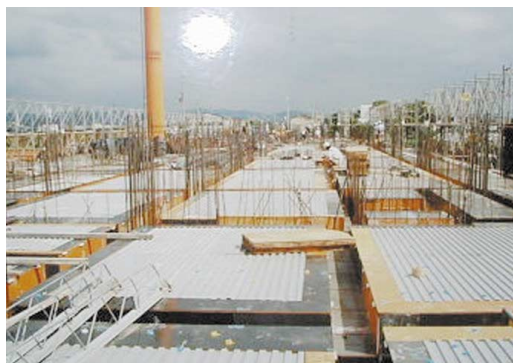
代替型枠( 資源保護に配慮し、従来の木製合板を使わないもの )の利用例 ( 京都市勤業館「みやこめっせ」 )
