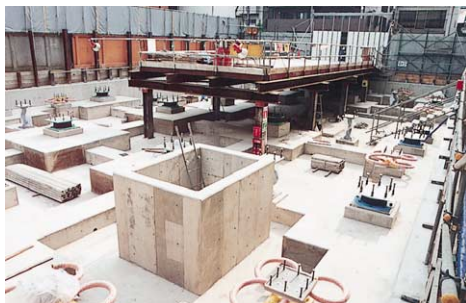
免震構造の施工現場
