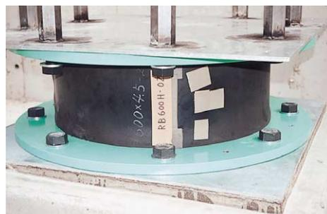
アイソレーター(積層ゴムを利用した免震装置)
