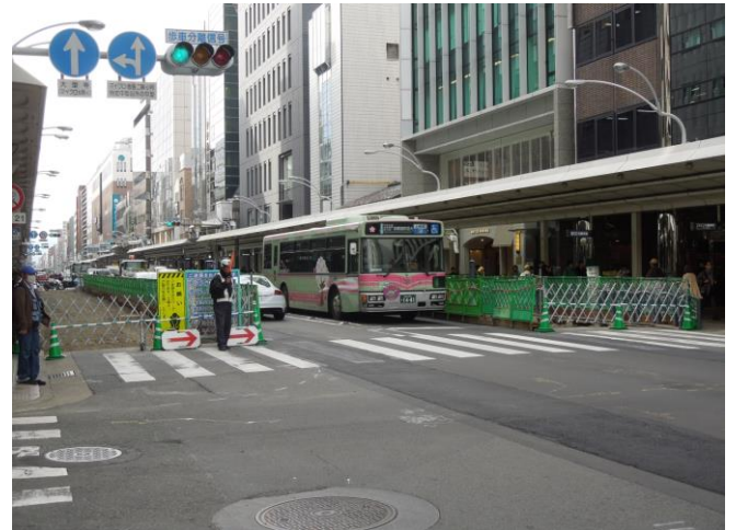
【工事中の四条通】
