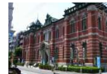
写真 3-15 三条通地区 (界わい景観整備地区)
