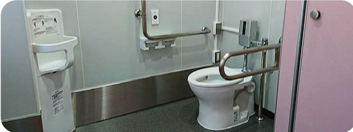
▲リニューアルされた市営住宅1街区集会所トイレ。 車イスの方も安心して使えるようになりました。
