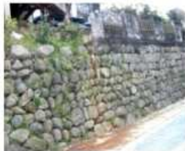
空石積造擁壁
