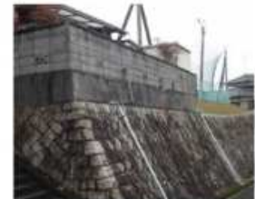
増し積み擁壁
