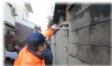
傾いたブロック塀の状況を確認(紫野学区)
