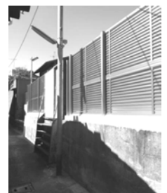
● 古いブロック塀を安全な塀に改善
