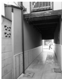
● 路地入口の建物の耐震改修
