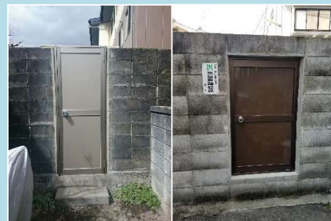
緊急避難扉設置
