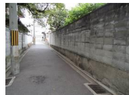
ブロック塀が続く道
