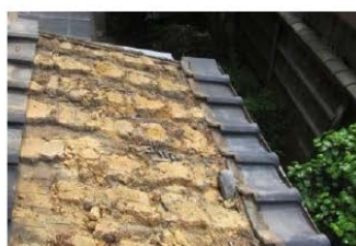
瓦の下に葺き土があり、瓦も経年劣化でもろくなり割れたり欠けたりしています。
