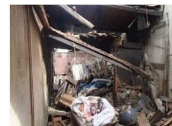
↑除却する前の空き家の様子。
