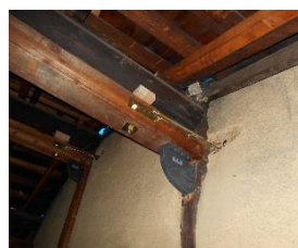
↑接合部を補強しました。 →トンネル路地の外観。
