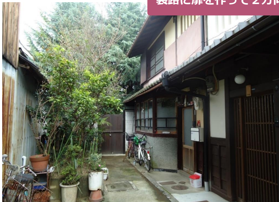
↑突き当たりが緊急避難扉。弁柄塗装の木製扉は、町並みに溶け込んでいます。
