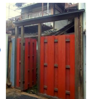
2つの袋路を隔てていた塀を除却し、扉付きの塀を新設。
