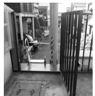
↑路地奥に設置した非常用扉と梯子
