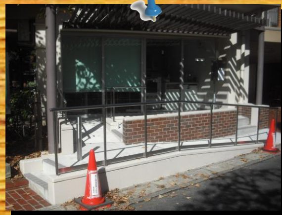
元の出入口も安全な階段を設置（正面）
