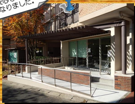
手すり付きのスロープを設置（正面右側）
