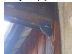
仕口ダンパー設置
