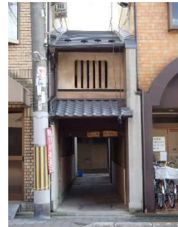
トンネル部分改修
