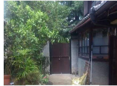
緊急避難扉の設置
