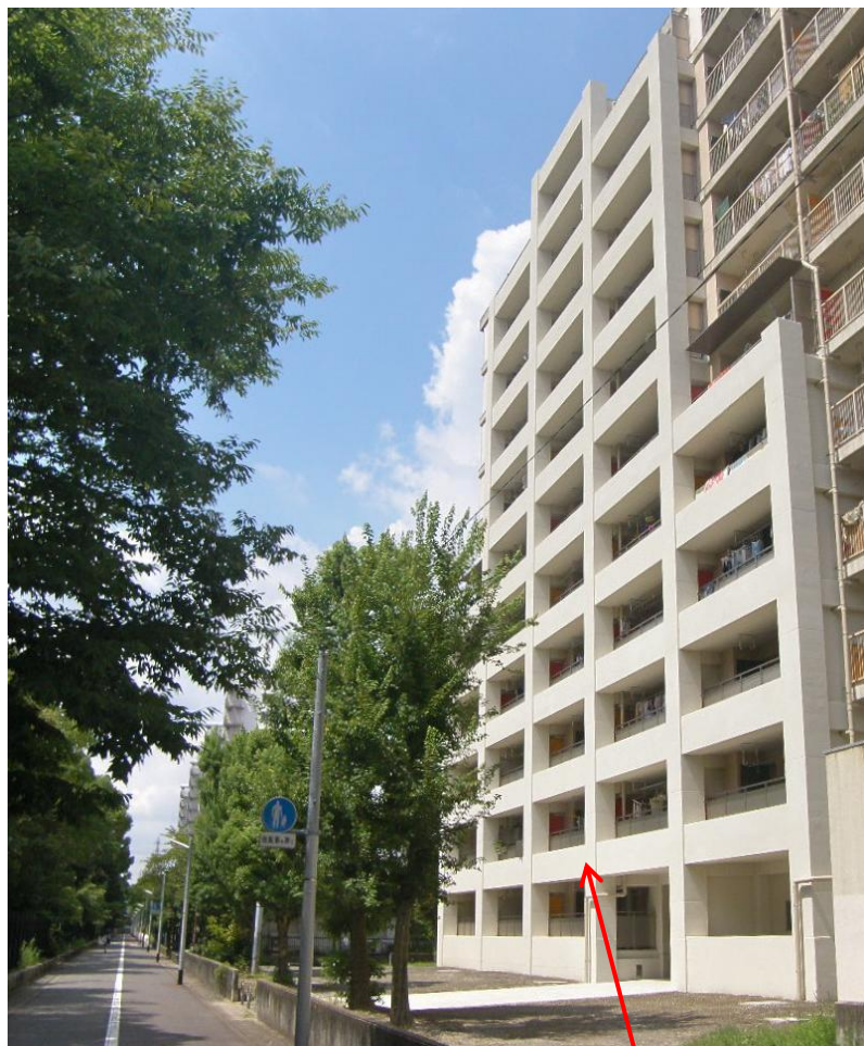
PCaアウトフレームによる補強
