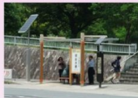
＜境谷大橋バス停の照明設置＞
