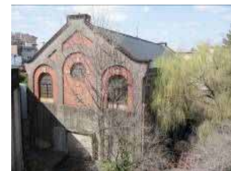
写真 2-94 蹴上発電所(非公開)
