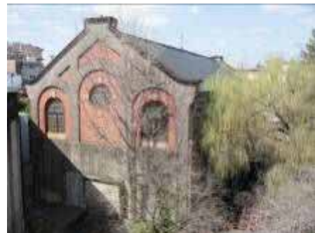
写真 2-94 蹴上発電所(非公開)
