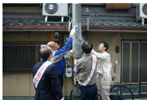
写真 7-27 屋外広告物の簡易除却
