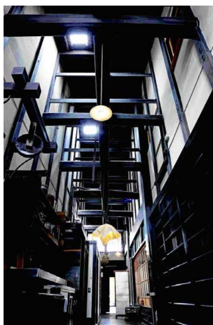
写真2-43 火袋 (小島家) 出典 「京町家の再生」
