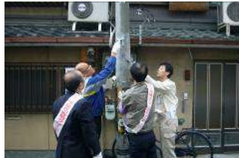
写真 7-27 屋外広告物の簡易除却
