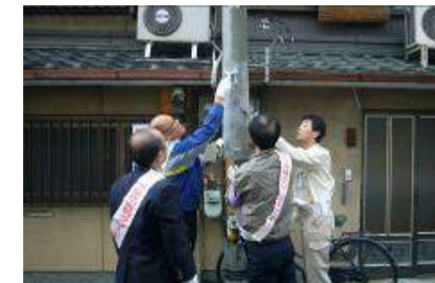
写真 7-27 屋外広告物の簡易除却
