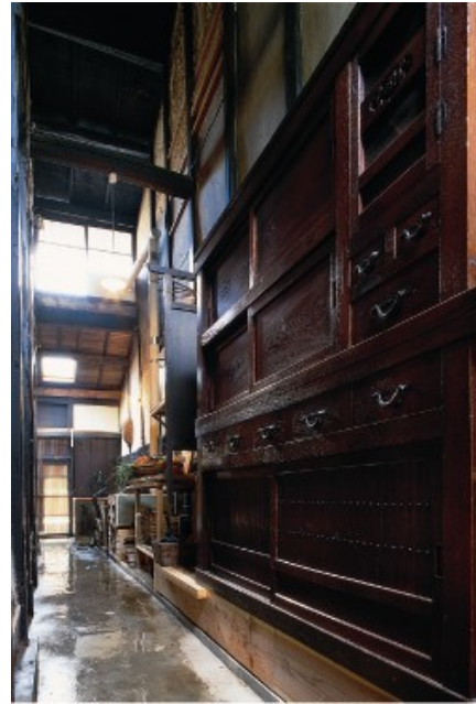
写真2-48 通り庭（町家写真館）
