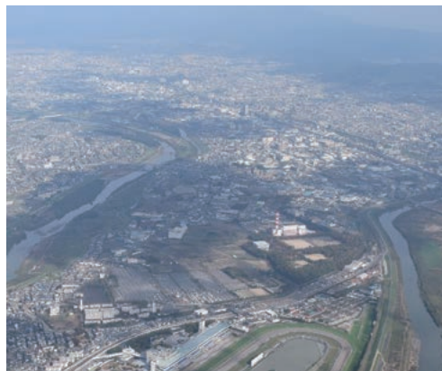
■土地区画整理事業（伏見西部地区）
