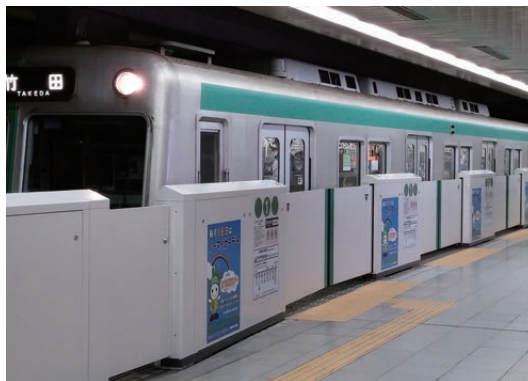
■可動式ホーム柵（地下鉄烏丸御池駅）
