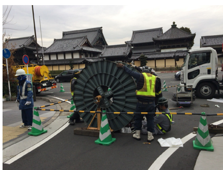
■下水道管更生の施工状況
