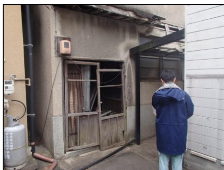
管理不全状態の建築物の調査の様子
