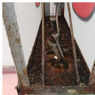
内部の腐食
