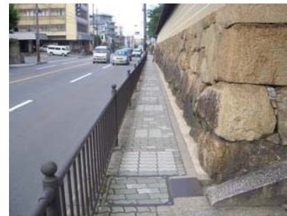
馬町周辺の歩道状況
